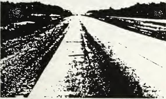
Fig. 3.2.4.1 — Longitudinal cracks
